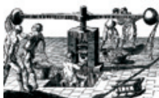
Distintos sistemas de acuñación de moneda: estampación manual con martillo, con molino de acuñación y mediante prensa de volante.
