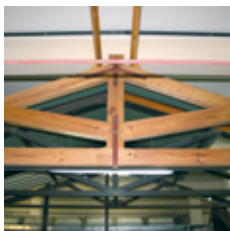
Cercha de madera (izquierda) y cimbras para arcos (derecha).
